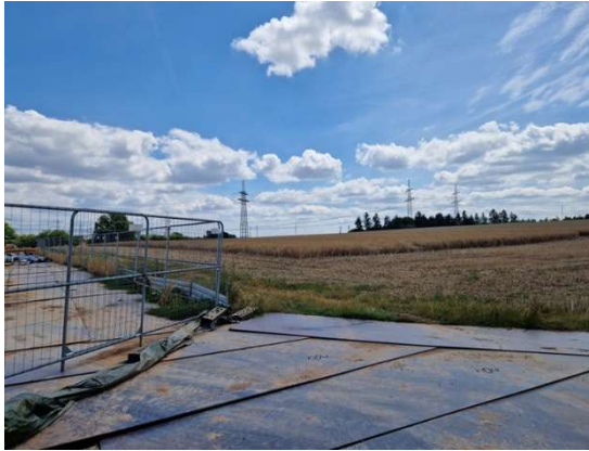
Abbildung 9: Zentraler Grünweg; Inanspruchnahme durch Bauvorhaben Mast.
