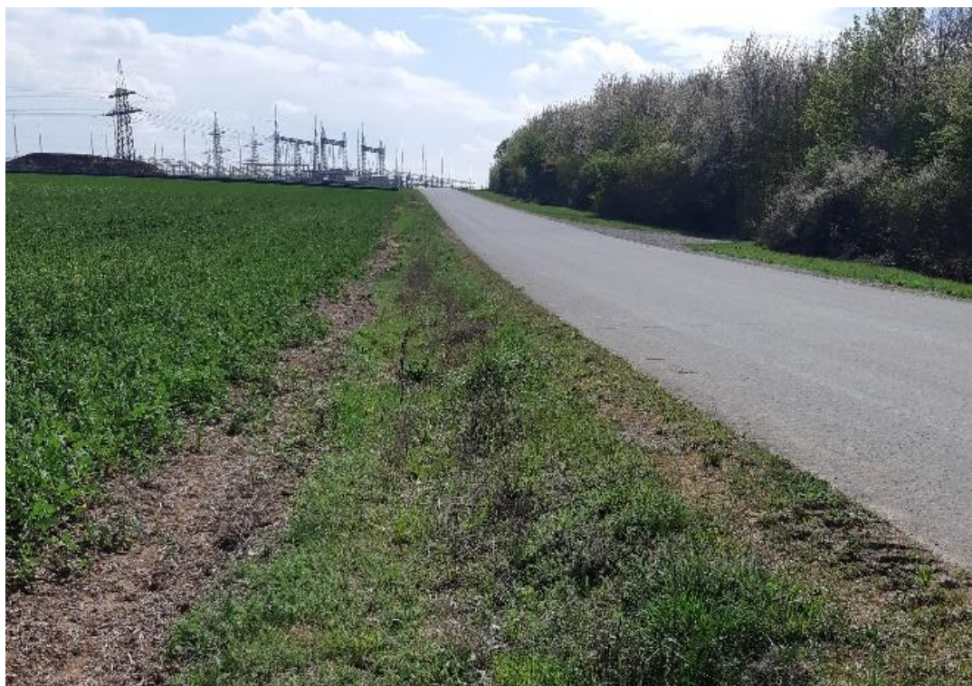
Abbildung 4: Blick nach Süden auf Umspannwerk Bergheinfeld-West und lineare Saumstruktur zwischen Fahrweg und Vorhabengebiet
