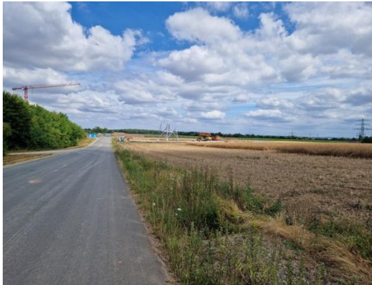
Abbildung 4: Blick entlang der Zufahrtsstraße nach Norden mit Ackernutzung, Waldparzelle und Baugeschehen, Masten und Konverterstation.
