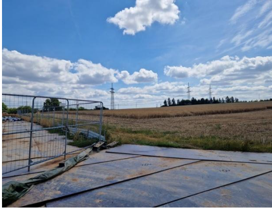
Abbildung 8: Zentraler Grünweg; Inanspruchnahme durch Bauvorhaben Mast.
