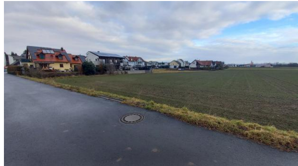
Nördlicher Geltungsbereich (Blick auf Fl. Nr. 716)
