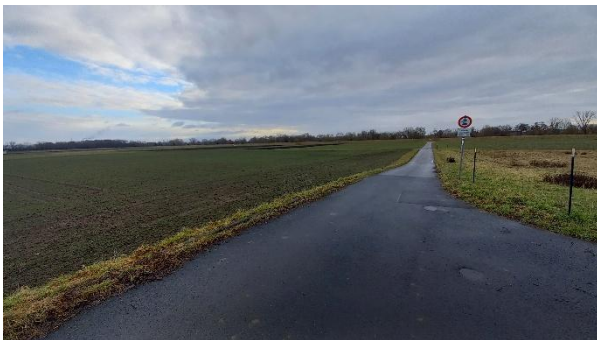
weiterführender Flurweg (Fl. Nr. 715) entlang des geplanten Grundstücks zur Regenrückhaltung
